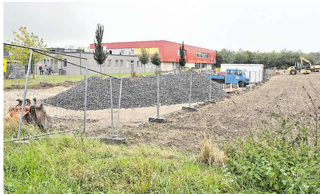
Die Bauarbeiten zur IGS-Erweiterung in Lengede haben begonnen. Im Hintergrund ist rechts im Schulgebäude und links die Mensa zu sehen.
